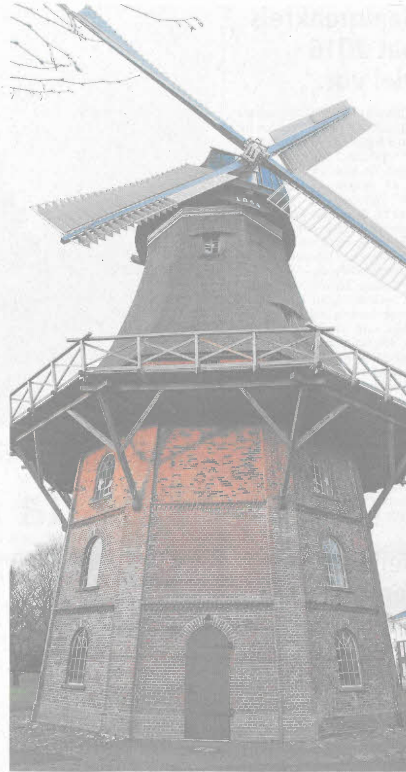
Die Galerie ist fertig, ein neuer Kopf ist drauf und die Flügel sind ebenfalls extra für die Schiffdorfer Mühle angefertigt worden. EU-Gelder aus dem Leaderprogramm haben es möglich gemacht. Foto Fixy
