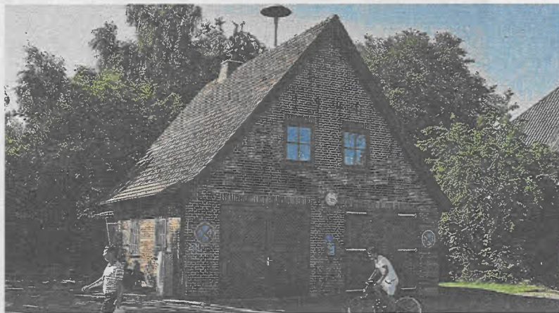
Das Bauhof-Gebäude in Bokel wird zu einem Treffpunkt für die Ortsgemeinschaft umgebaut. Die Tore werden zurückgebaut. Archivfoto Schönig
